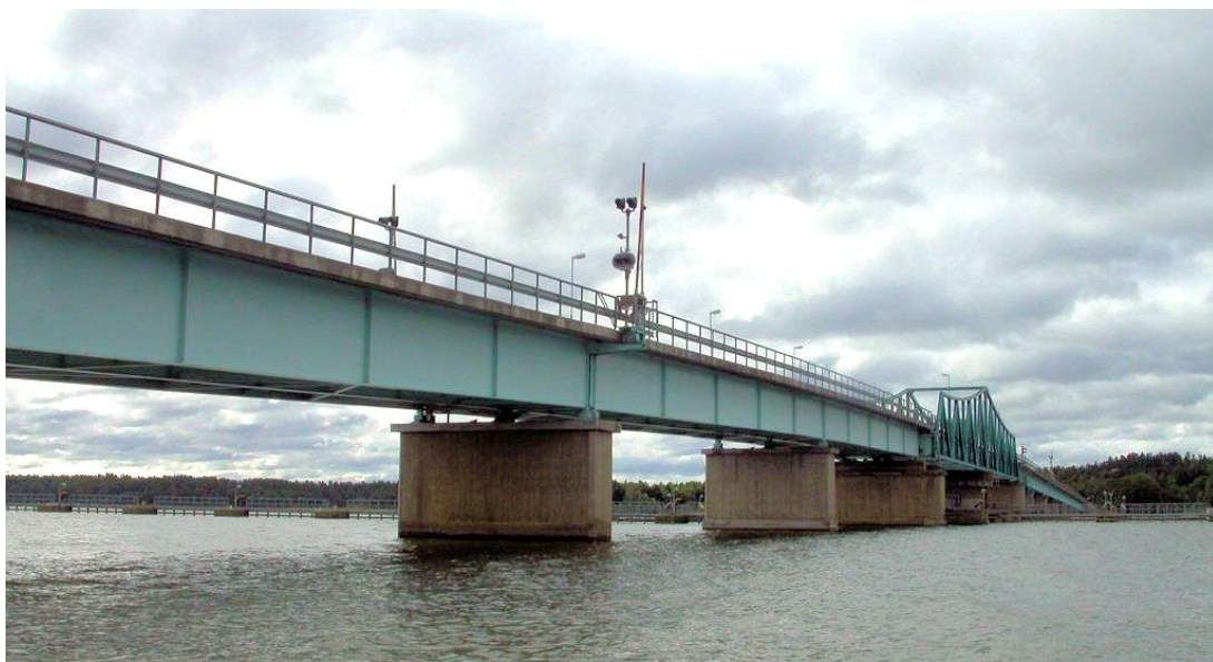
Figur 3 Befintlig bro fotograferad från sydväst.
