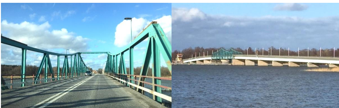
Figur 9 Hjulstabrons fackverkskonstruktion till vänster och bron sedd från Märsön på högra bilden.
