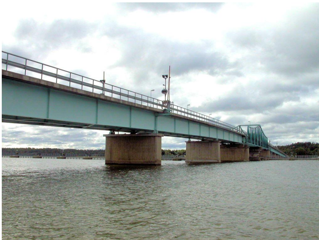
Figur 4 Befintlig bro fotograferad från sydväst.
